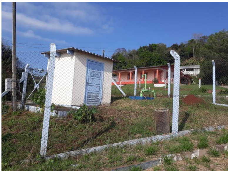
Figura 17. Ponto de captação de água.
